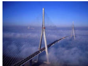
Pont de Normandie, France
